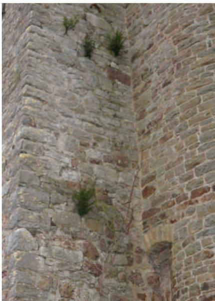
La végétation détruit les maçonneries en s'y enracinant et provoque une humidité permanente au niveau des murs, et est donc particulièrement néfaste.
