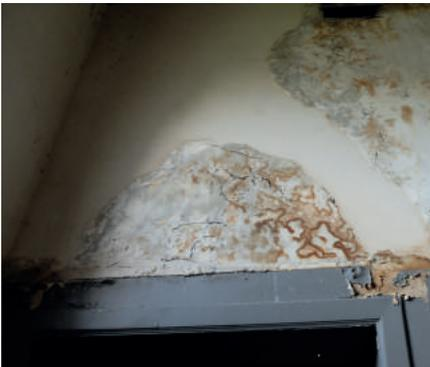
Les conséquences d'une infiltration d'eau : la peinture se soulève et s'écaille, des taches apparaissent sur les murs et des mousses se développent au niveau des zones les plus humides.
